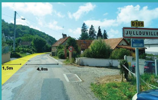
Matérialisation d'un cheminement piétons
