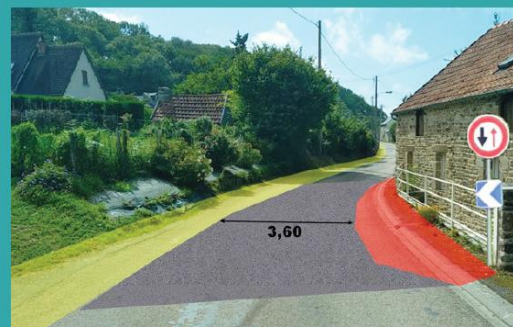
Matérialisation d'écluses pour chaque sens de circulation avec une perte de priorité cassant la vitesse
