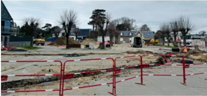
**Les travaux avancent bien et les délais sont tenus.** La première phase a consisté à l'enfouissement des réseaux électriques, de téléphone, de la fibre et de l'éclairage dans les avenues bordant la place et le parking du marché et les raccordements vers les parties privatives. Ces travaux se sont terminés fin février.
